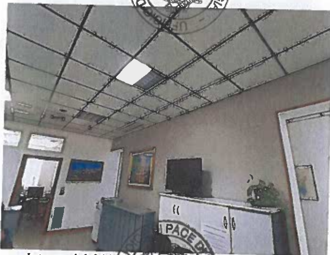
Interno del fabbricato in Penne via san Francesco
