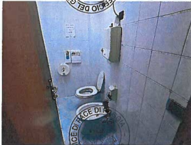
interno del fabbricato in Penne via san Francesco
